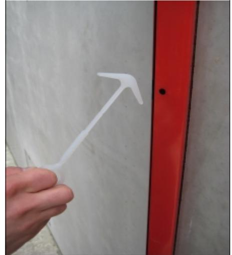
**3** Drehen + Ziehen des FLUXX Ankers zur Arretierung der FLUXX Schiene
